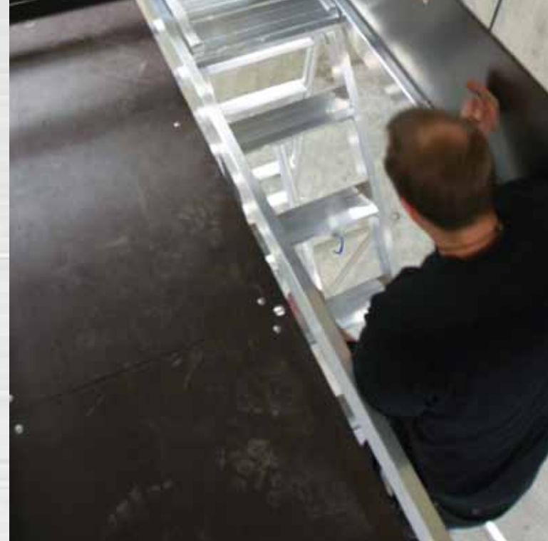
Rullställning 0,7 x 1,7 m. Övre plattformshöjd 2,32 m (totalhöjd 3,47 m).
